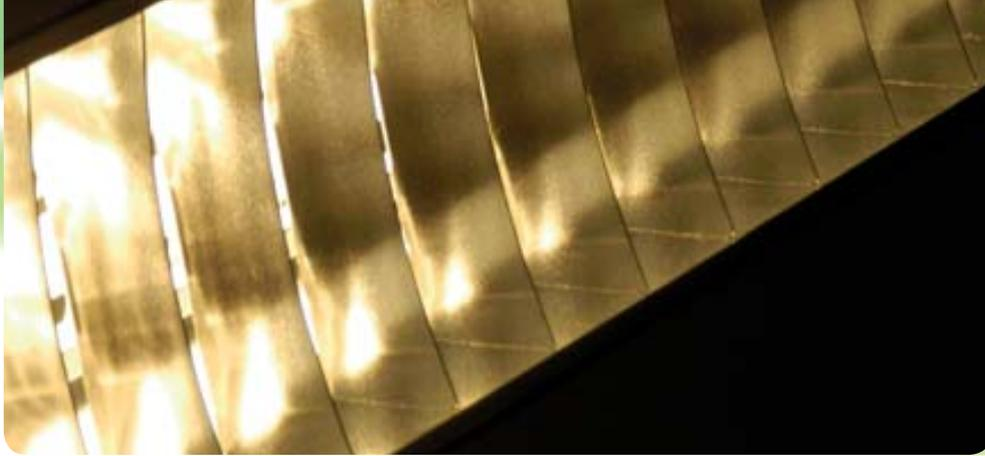
Détails des luminaires dans le bâtiment BvS, le réglage de l'intensité lumineuse se fait individuellement via un logiciel de contrôle accessible sur chaque PC.
